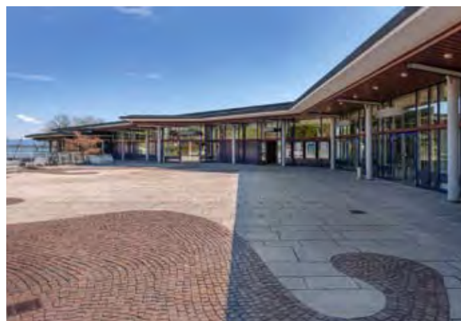
Abb. 143 Eingangsbereich mit ausladendem Vordach
