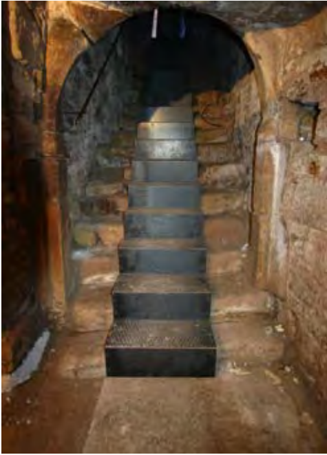
Abb. 64 (oben links) Sofern die Treppe mit ihren Altersspuren erhalten werden soll, eine Reparatur gestalterisch nicht gewünscht oder aus wirtschaftlichen Überlegungen nicht möglich ist, kann auch eine „Überbauung“ der bestehenden Stufen durch eine neue Laufebene als Konzept in Frage kommen. Je nach Raumnutzung sind auch die Anforderungen der Barrierefreiheit einzuhalten.
