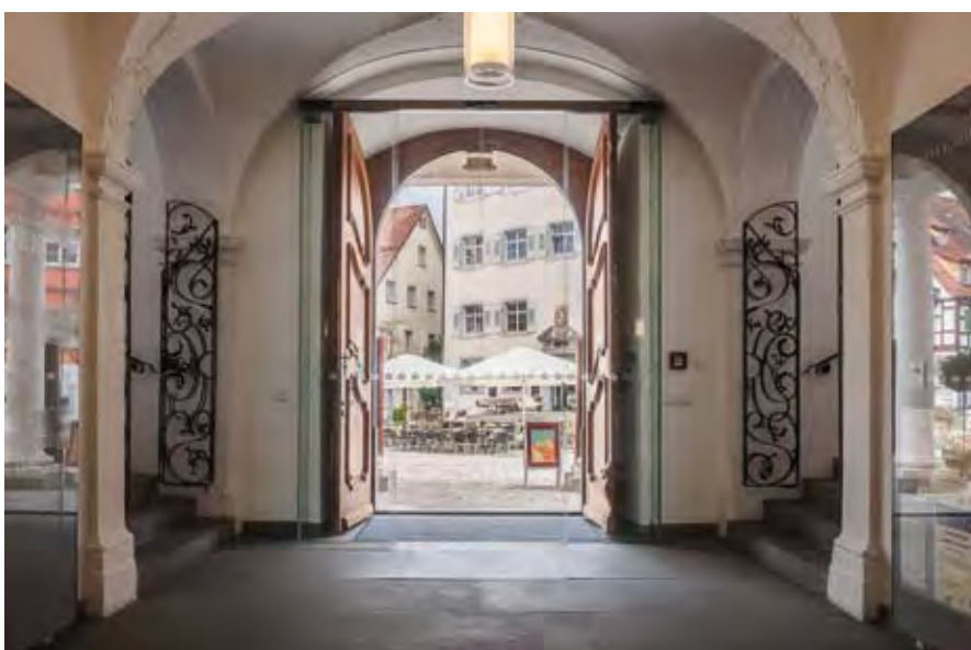
Abb. 121 und 122 Die schwere bauzeitliche Außentür steht zu Öffnungszeiten offen, den Wetterabschluss bildet dann die selbstöffnende Glaschiebetüre im Gebäudeinneren.
