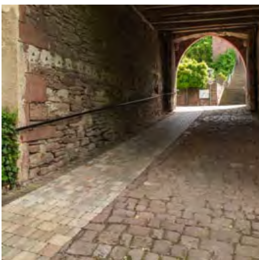
Abb. 23 Der Ersatz von schwer befahr- oder begehbaren Pflastersteinen und das Anlegen eines separaten Geh-/Fahrstreifens wie in Tiefenbronn-Mühlhausen (Zugang zum Pfarramt) ist eine denkmalverträgliche Lösung, die sich in besonderer Weise bei Flächen eignet, die ohne ornamentale Gestaltung angelegt sind.
