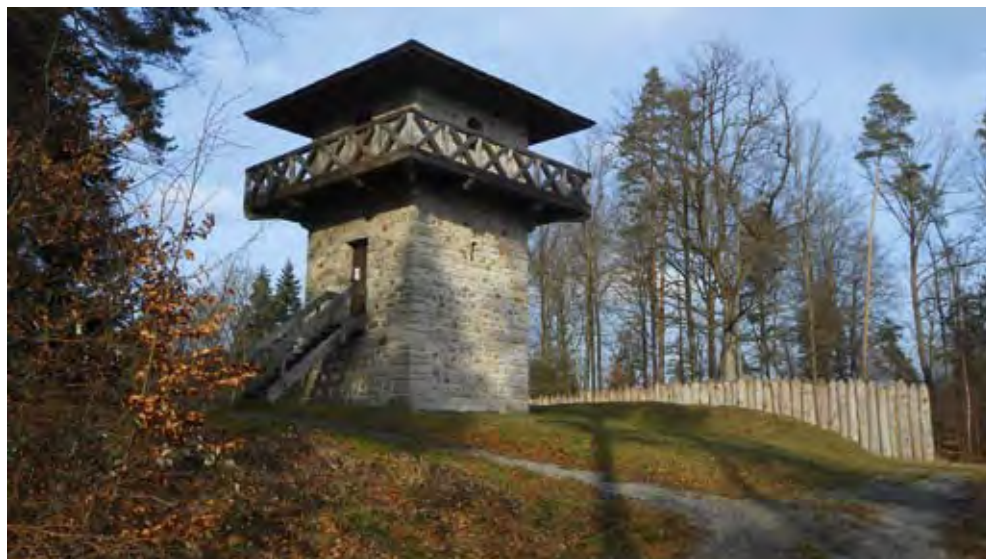
Abb. 154 Rekonstruierter Limesturm bei Grab
