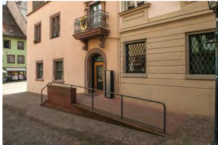
Abb. 45 Das Rottweiler Treppen-Rampenmotiv wurde auch am Rathaus angewandt. Dort ist der Podestbereich noch mit einer Briefkasten-Klingelanlage ausgestattet und ein externer Taster ermöglicht das automatische Türöffnen.
