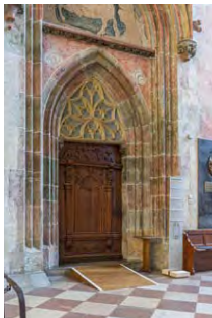
Abb. 68 und 69 Mobile Rampen aus Stahl (Neues Schloss Meersburg) oder Holz (Ulmer Münster) ermöglichen nicht nur den Zugang für Menschen im Rollstuhl, sondern können auch der Versorgung höher gelegener Räume dienen.
