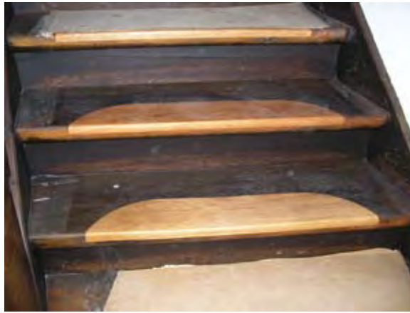
Abb. 64 (oben links) Sofern die Treppe mit ihren Altersspuren erhalten werden soll, eine Reparatur gestalterisch nicht gewünscht oder aus wirtschaftlichen Überlegungen nicht möglich ist, kann auch eine „Überbauung“ der bestehenden Stufen durch eine neue Laufebene als Konzept in Frage kommen. Je nach Raumnutzung sind auch die Anforderungen der Barrierefreiheit einzuhalten.
